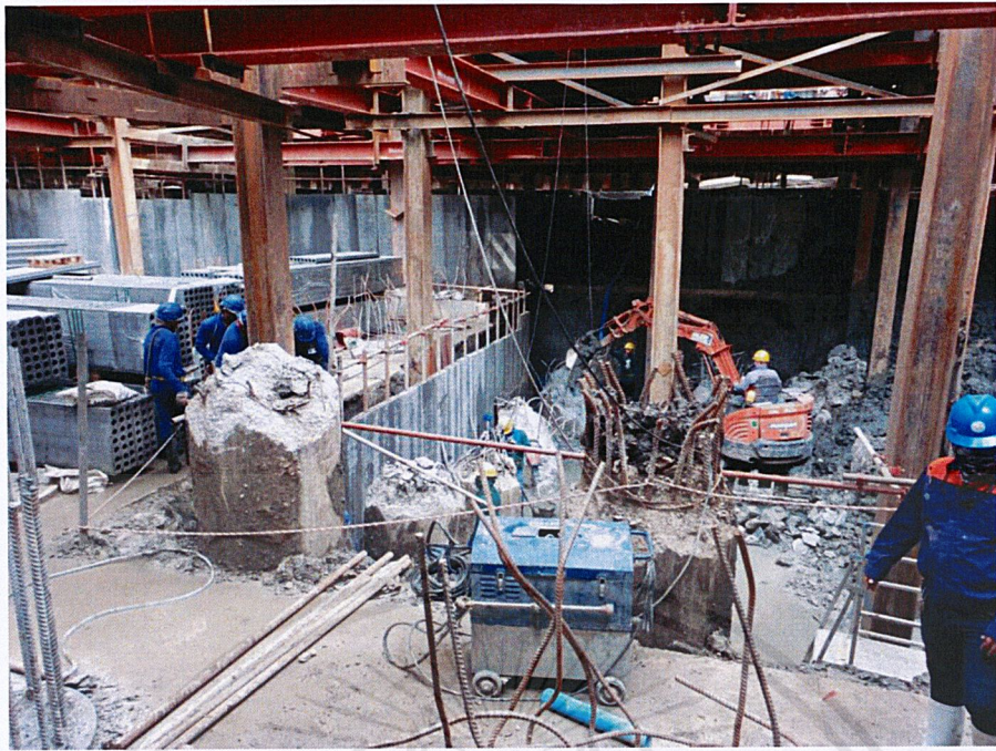
ภาพที่ 4.9 แสดงการใช้แบบหล่อกับงาน Mat Foundation
