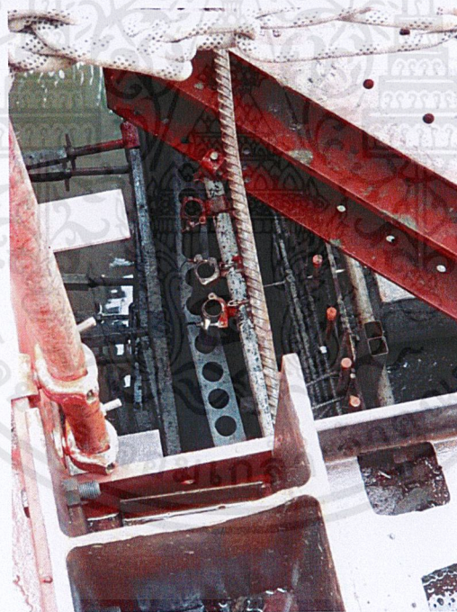
ภาพที่ 4.6 แสดงปัญหาเคลื่อนตัวออกจากแนวขณะเทคอนกรีต
