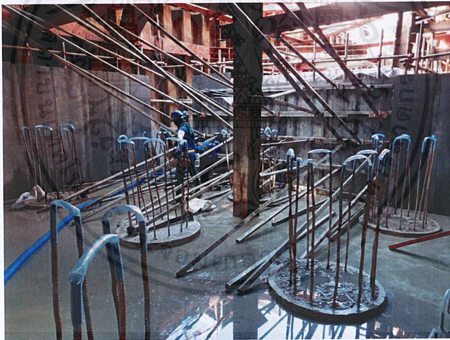
ภาพที่ 4.8 แสดงรูปแบบการค้ำยันแบบหล่อ
