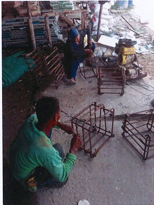
ภาพที่ 1 แสดงการผูกเหล็กเส้นด้วยลวดเบอร์ 18
