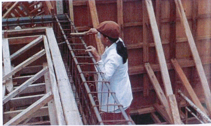
ภาพที่ 5.1 แสดงการขัดสนิมเหล็กคานหน้าสนาม ด้วยแปรงโลหะ
