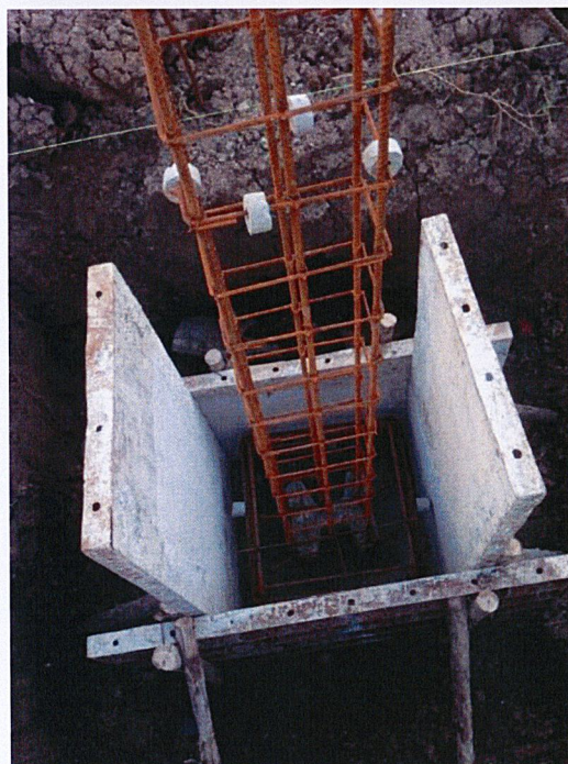
ภาพที่ 5 แสดงการตรวจสอบความถูกต้องในระดั, ตำแหน่งศูนย์กลาง และเหล็กเสริมในงานฐานราก
