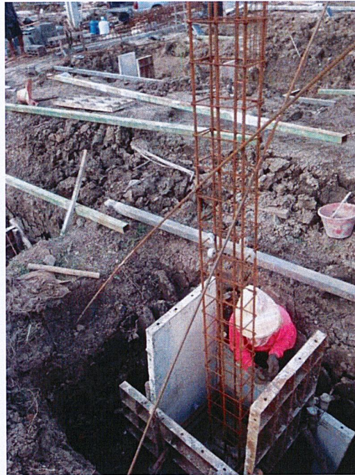
ภาพที่ 4 แสดงการติดตั้งเหล็กเสริมฐานราก, เสาคอม่อและเสาชั้นล่าง
