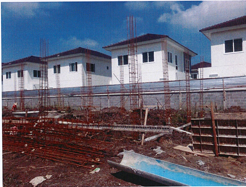
ภาพที่ 5.2 แสดงการใช้เหล็กเสริมค้ำยันเหล็กเสา
