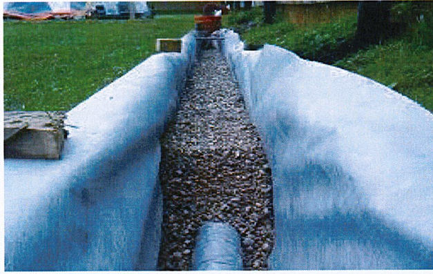
รูปที่ 2.13 การปูแผ่นใยสังเคราะห์ GEOTEXTILE ในการปูเพื่อวางท่อระบายน้ำใต้ดิน (ที่มา : https://www.kontraststroy.ru/ )
