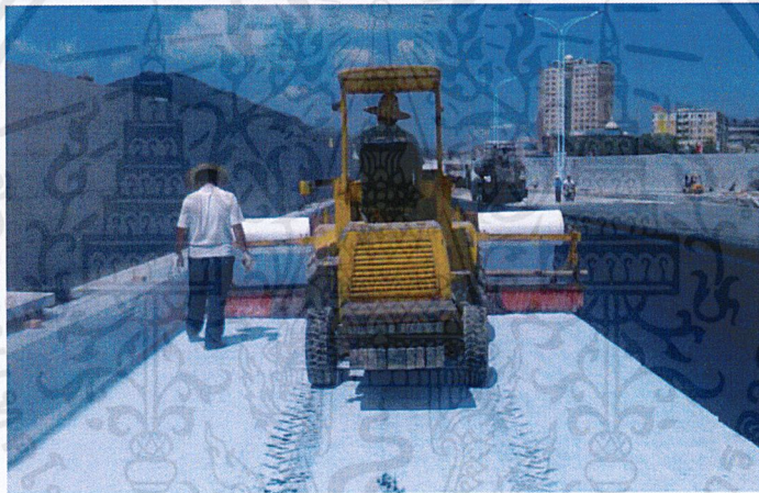
รูปที่ 2.15 การปูแผ่นใยสังเคราะห์ GEOTEXTILE ในการปูเพื่อเสริมกำลังวัสดุ (ที่มา : http://thai.industrialfeltfabric.com/ )
