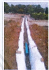
แผ่นรองและคลุมท่อระบายน้ำ
