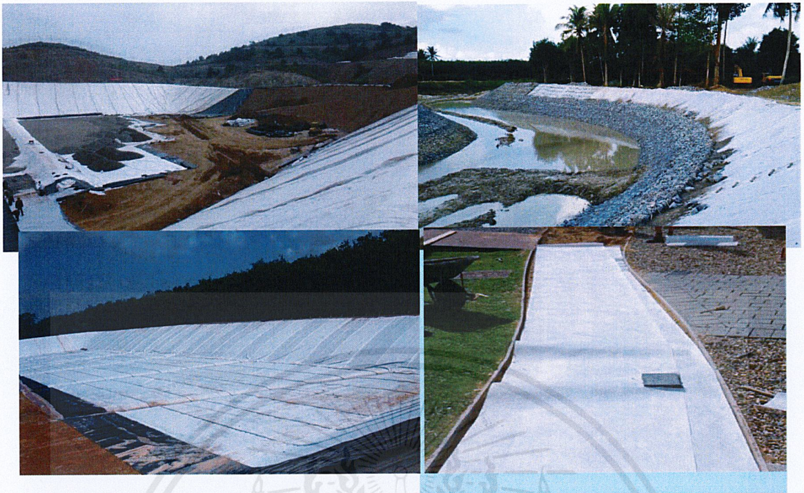
รูปที่ 2.12 การปูแผ่นใยสังเคราะห์ GEOTEXTILE ในการปู่อและปูคลุม (ที่มา : https://www.marineshine.co.th/ )
