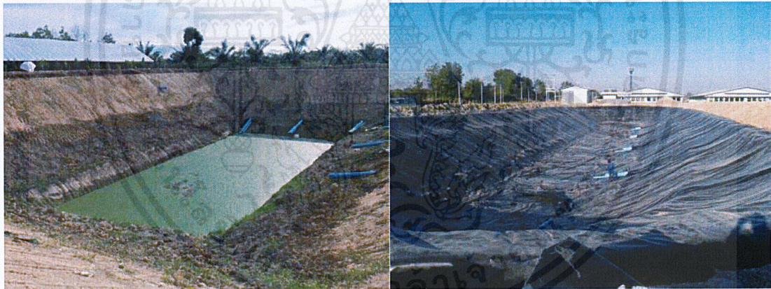
รูปที่ 2.6 การใช้แผ่น Geomembrane ในการปูรองบ่อบำบัดน้ำเสีย
