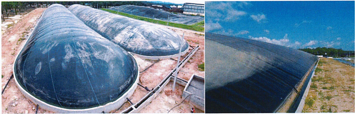
รูปที่ 2.5 การใช้แผ่น Geomembrane ในการคลุมปิดปากบ่อบำบัดน้ำเสีย หรือก๊าซชีวภาพ
