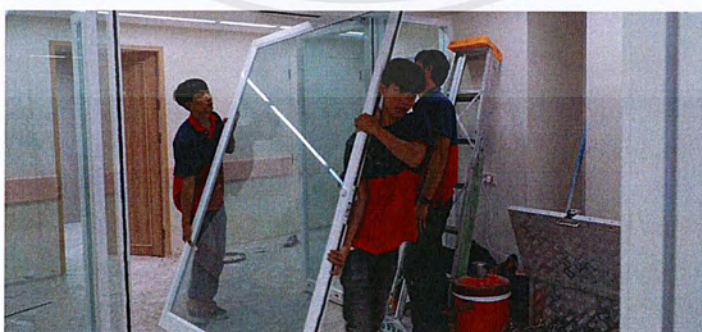
ภาพที่ 3.8 ช่างติดตั้งอะลูมิเนียม
