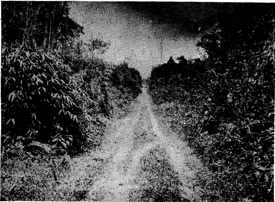
ทางรถไฟที่ยังไม่ได้วางราง ใช้เป็นทางเดินรถยนต์และรถแทรกเตอร์
