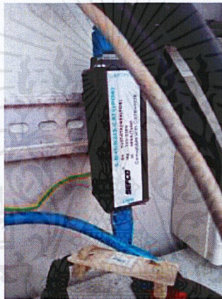
รูปที่ 3.11 การติดตั้งอุปกรณ์ป้องกันแรงดันเกินสำหรับสายสัญญาณของกล้อง CCTV No.15
