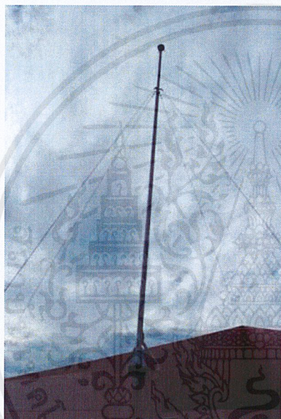
รูปที่ 2.6 แท่งล่อฟ้า Early Streamer Emission
