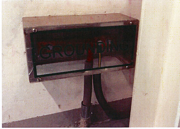
รูปที่ 3.24 จุดเชื่อมต่อกราวด์ภายในห้อง
