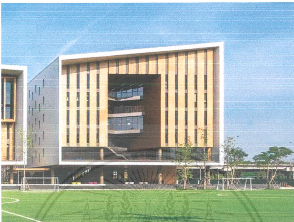
ภาพที่ 1. 36 แสดงภาพภายนอกอาคารC
