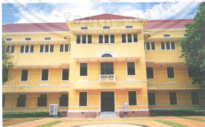
ภาพที่ 1.47 แสดงบริเวณด้านหลังอาคารกระทรวงพาณิชย์ (เดิม) กรุงเทพฯ
