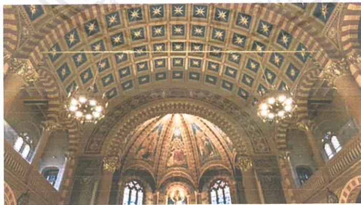
ภาพที่ 1.59 แสดงโครงสร้างเสาและเพดานอาสนวิหารอัสสัมชัญ กรุงเทพฯ
