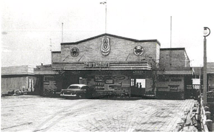
ภาพตัวอาคารตรงปลายสะพานที่เป็นร้านอาหาร
