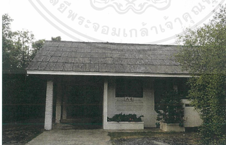
รูปที่ 1.34 รูปด้านหน้าอาคารบ้านพัก
