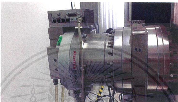
ภาพที่ 3.7 Turbo Pump ที่ใช้ในระบบ จากบริษัท PFEIFFER Vacuum
