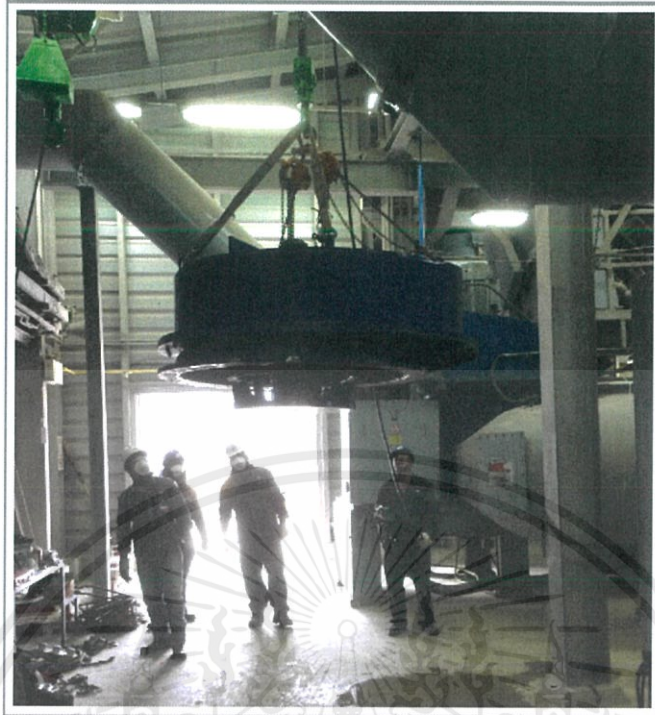
รูปที่ 3.49 ลักษณะการประกอบเครื่องบดหินปูน
