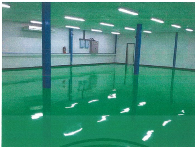
ภาพที่ 2.7 การเคลือบพื้นผิวด้วยอีพอกซีเรซิน [4]
