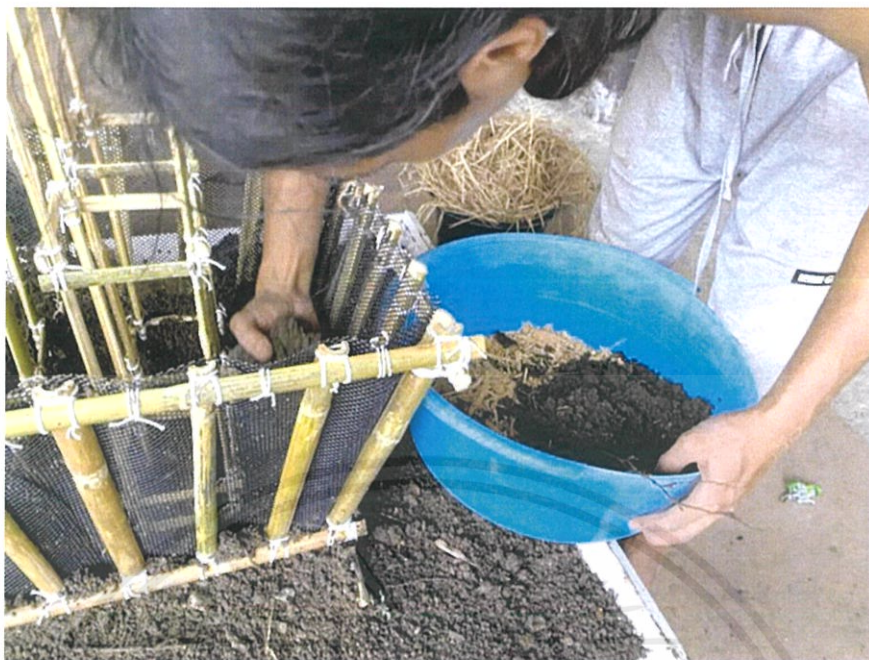
ภาพที่ 3.37 เอาดินลงฐาน
