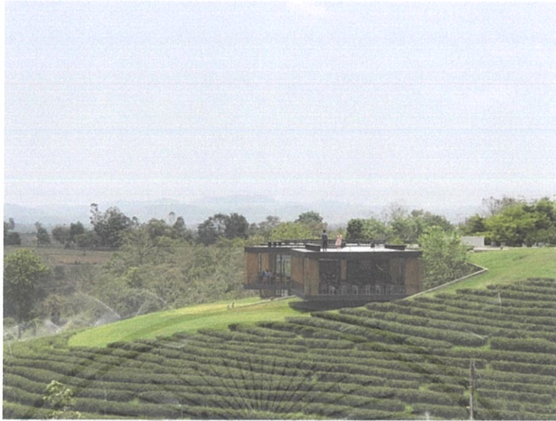
ภาพที่ 1.16 แสดงภาพภายนอกของอาคาร A
