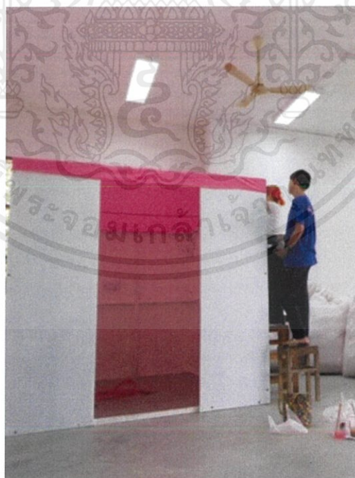
ภาพที่ 31 การประกอบผนังเพื่อกำหนดขอบเขตของชิ้นงานและชิงผ้าด้านบน
