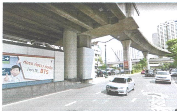
ภาพที่ 1. 29 แสดงทัศนียภาพทางทิศตะวันตก ติดกับรถไฟฟ้า BTS สถานีราชเทวี
