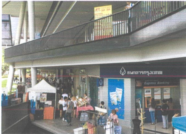
ภาพที่ 1. 87 แสดงทัศนียภาพภายนอกอาคาร A8
