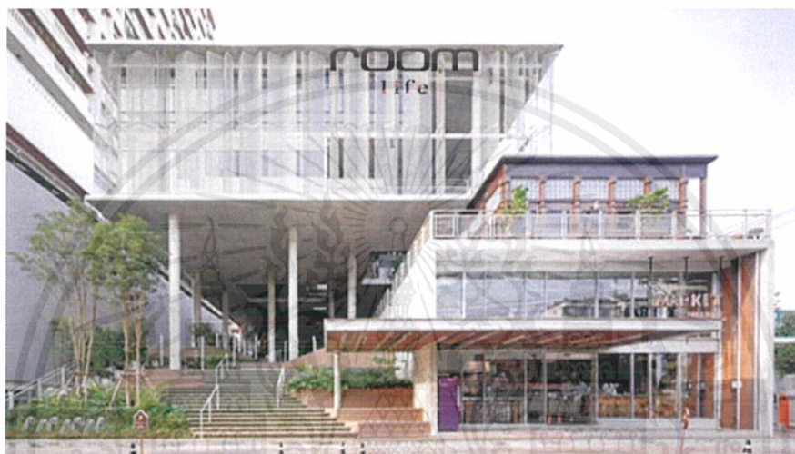
ภาพที่ 1.20 แสดงภาพด้านหน้าของอาคาร C (ที่มา : www.baanlaesuan.com )
