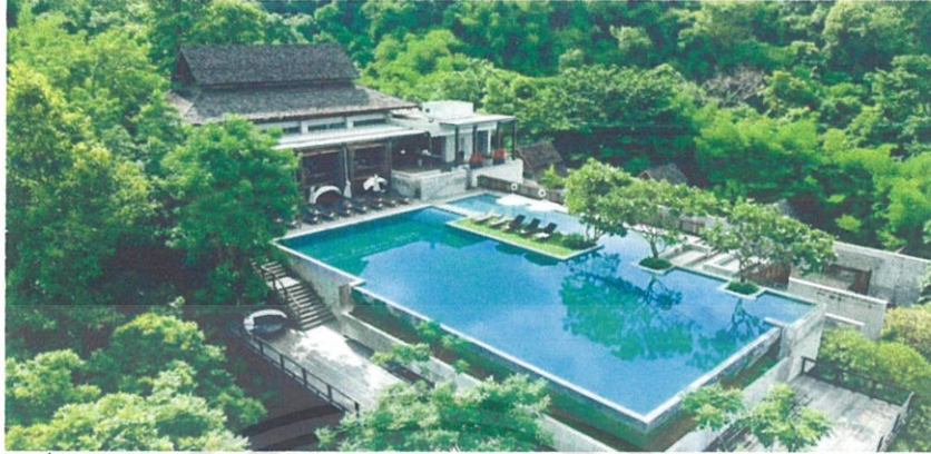
ภาพที่ 1.42 อาคาร RESTAURANT & SPA : Veranda High Resort , เชียงใหม่ ที่มา: https://www.verandaresort.com/verandachiangmai/ วันที่ 1 สิงหาคม 2562
