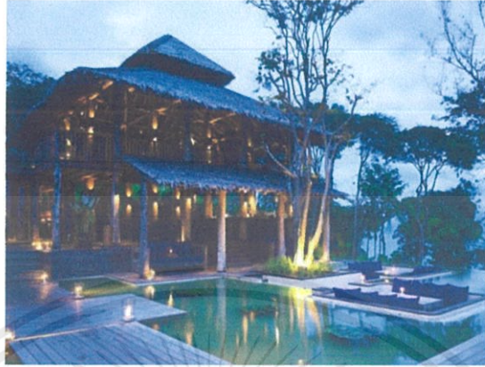
ภาพที่ 1.27 อาคาร LOBBY : Six Senses Yao Noi Resort and Spa , พังงา ที่มา: https://www.sixsenses.com/en/resorts/yao-noi วันที่ 1 สิงหาคม 2562
