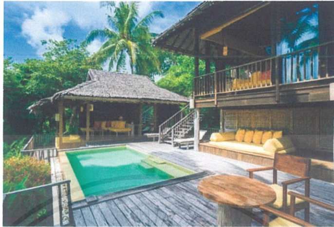
ภาพที่ 1.30 อาคาร Beachfront Pool Villa Suite : Six Senses Yao Noi Resort and Spa , พังงา ที่มา: https://www.sixsenses.com/en/resorts/yao-noi วันที่ 1 สิงหาคม 2562
