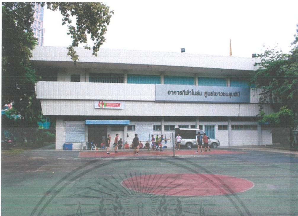
ภาพที่ 1.30 ภาพบริเวณด้านหน้าอาคารกีฬาในร่ม (1 กันยายน 2562)
