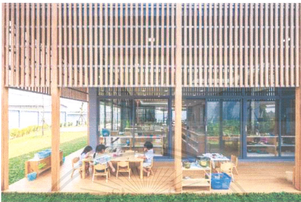
ภาพที่ 1.7.2.8 ภาพแสดงรูปถ่ายอาคาร Ratchut School ที่มา https://www.archdaily.com/896045/ratchut-school-design-in-motion (วันที่ 10 สิงหาคม 2562)
