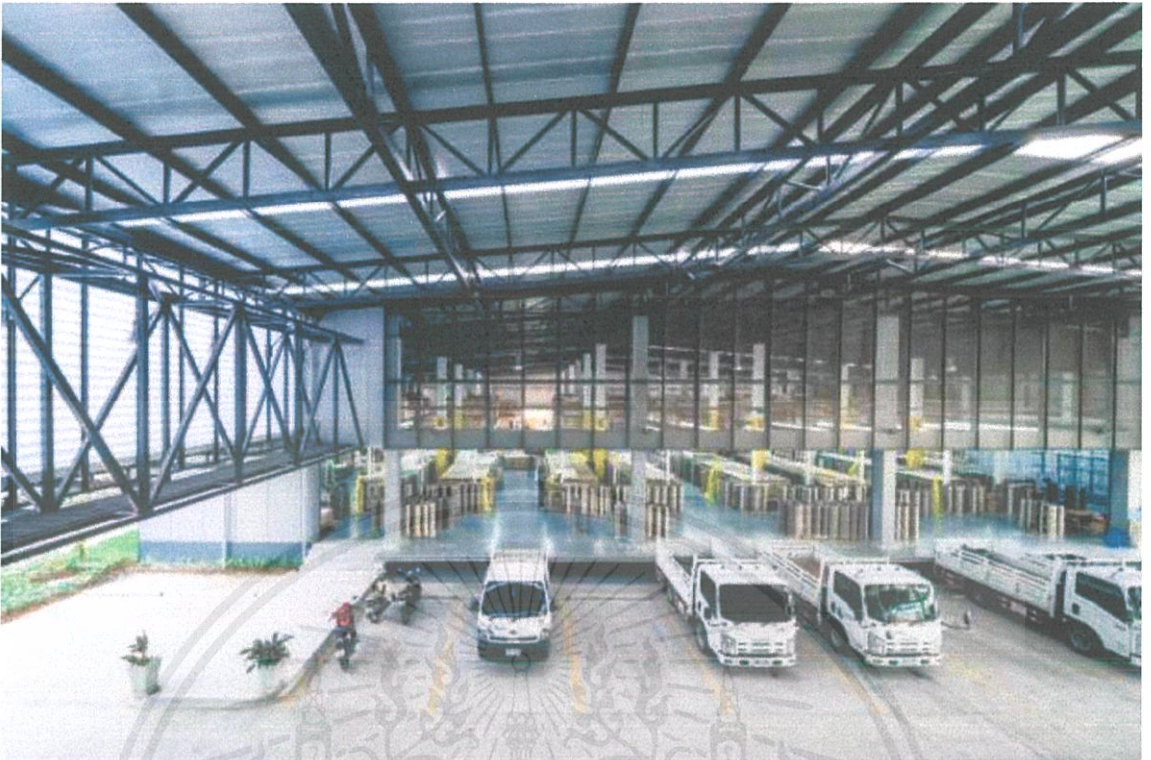
ภาพที่ 1.7.2.2 ภาพแสดงภายในอาคาร Tak Sale Office and Warehouse ที่มา https://www.archdaily.com/888244/tak-sale-office-and-warehouses-aomo (วันที่ 10 สิงหาคม 2562)
