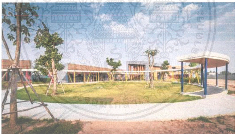
ภาพที่ 1.7.2.9 ภาพแสดงรูปถ่ายอาคาร Ratchut School ที่มา https://www.archdaily.com/896045/ratchut-school-design-in-motion (วันที่ 10 สิงหาคม 2562)
