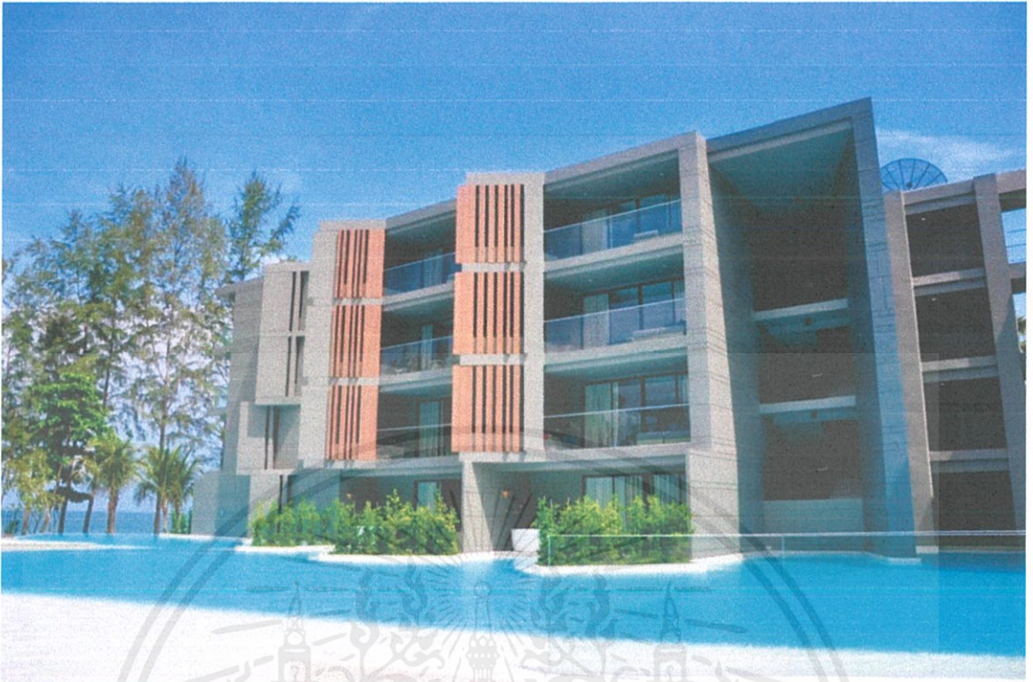
ภาพที่ 1.82 ลักษณะอาคารโครงการ (ต่อ)
