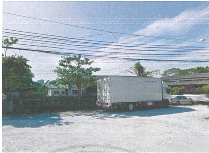
ภาพที่ 1. 18 แสดงภาพทัศนียภาพติดกับพื้นที่ว่าง ที่จอดรถ
