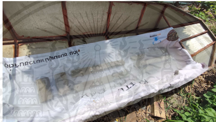
รูปที่ 4.9 การบ่มเปียกของคอนกรีต
