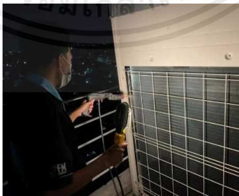
รูปที่ 3.8 ฉีดน้ำแรงดันสูงล้างแผงคอยล์ร้อน
