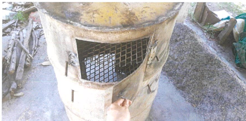
ภาพที่ 3.46 นำตะแกรงเหล็กใส่ในถังและนำเหล็กมาขัดเพื่อวางตะแกรง
