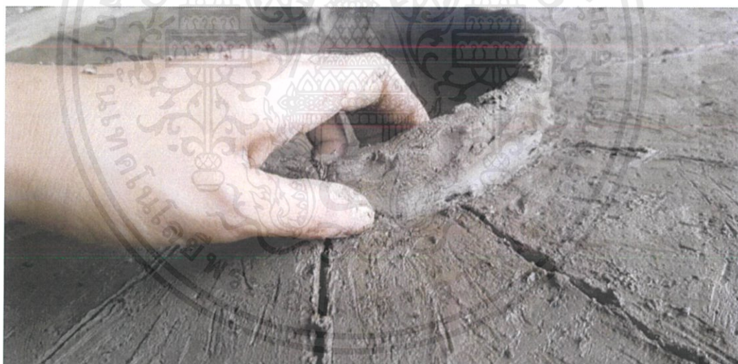
ภาพที่ 3.29 กดดินให้ผสานกัน
