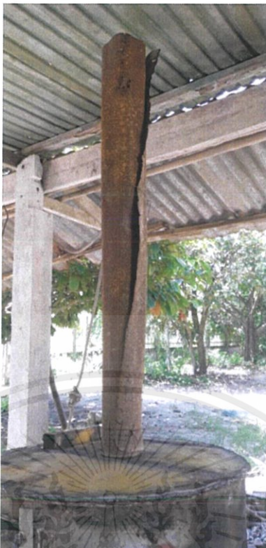
ภาพที่ 3.44 แผ่นสังกะสีที่นำมาฉนวนทำเป็นปล่องควัน
