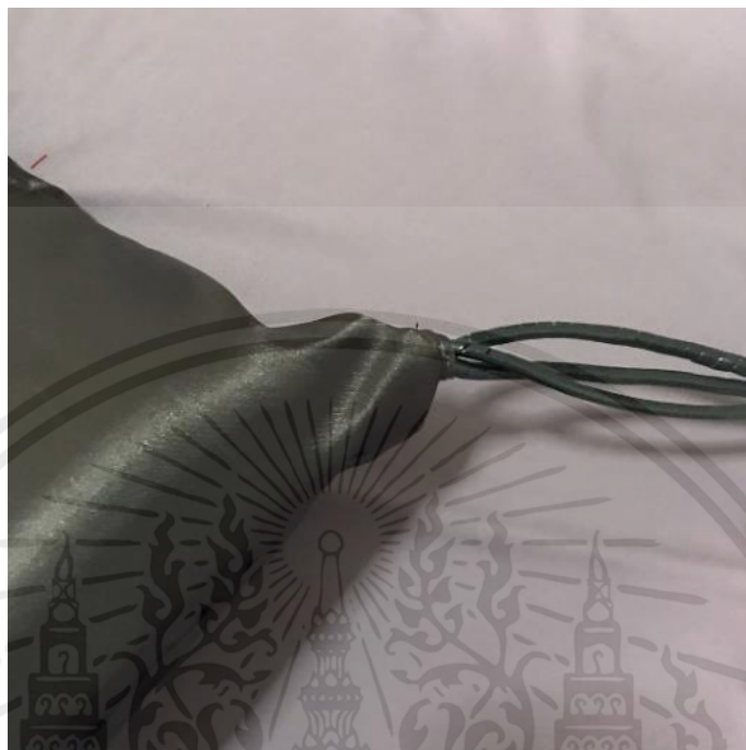
รูปที่ 3.22 การลอดสายไฟผ่านช่องปลอกเบา
