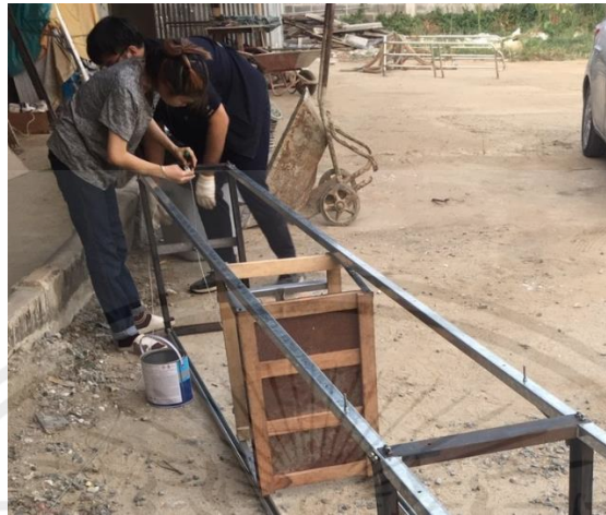
รูปที่ 4.24 การประกอบโครงเหล็กด้านบน
