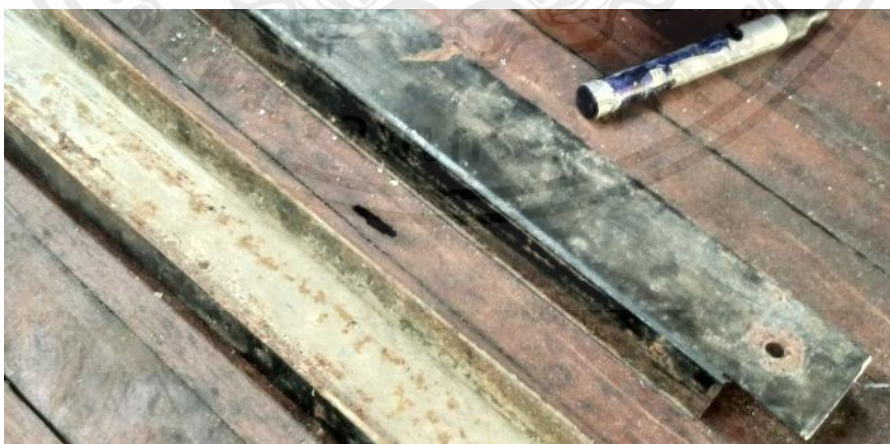
รูปที่ 4.14 การเจาะรูเหล็กตัวซี
