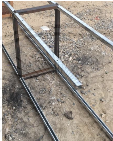
รูปที่ 4.22 การประกอบโครงเหล็กด้านล่าง
