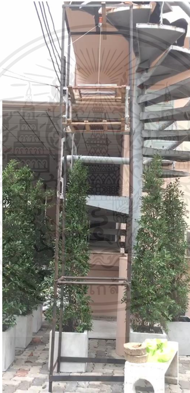
รูปที่ 3.22 ชิ้นงานที่ 1 เสร็จสมบูรณ์
