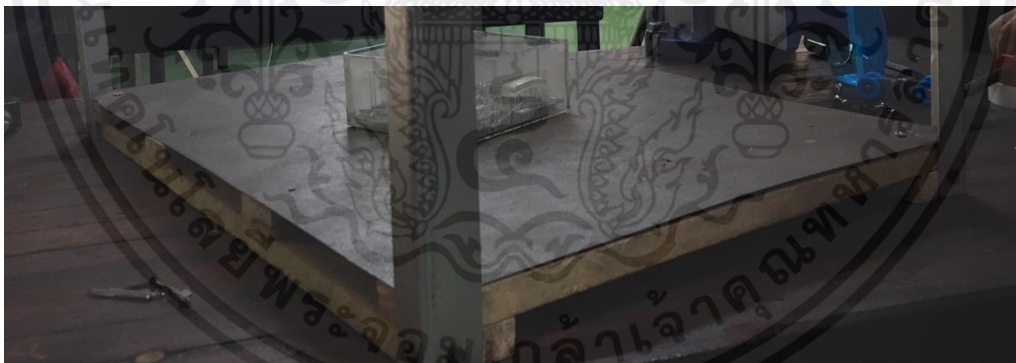
รูปที่ 4.19 การประกอบโครงไม้กับแผ่นเหล็กบางพับฉาก
