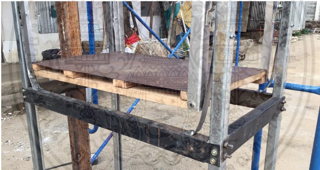
รูปที่ 4.26 การติดตั้งระบบชะลอความเร็ว
