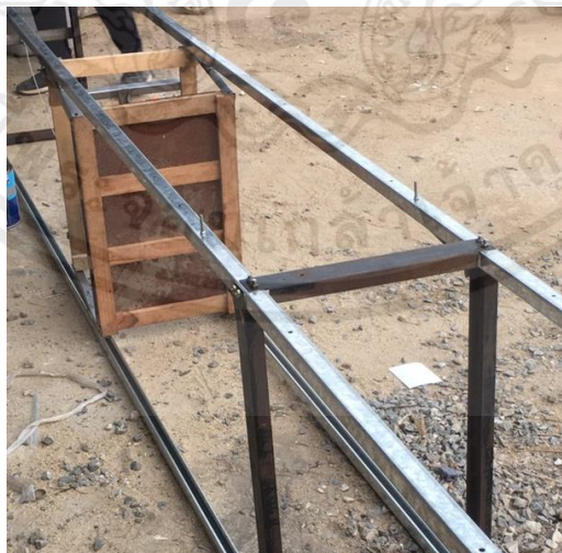
รูปที่ 4.23 การประกอบแผ่นลำเลียงเข้ากับโครงเหล็ก
