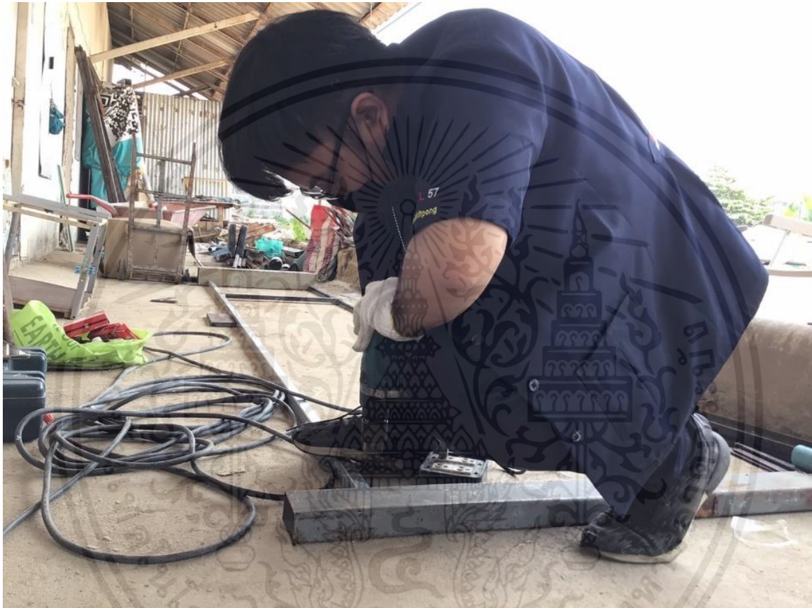
รูปที่ 4.15 ขั้นตอนการเจาะรูโครงเหล็ก
