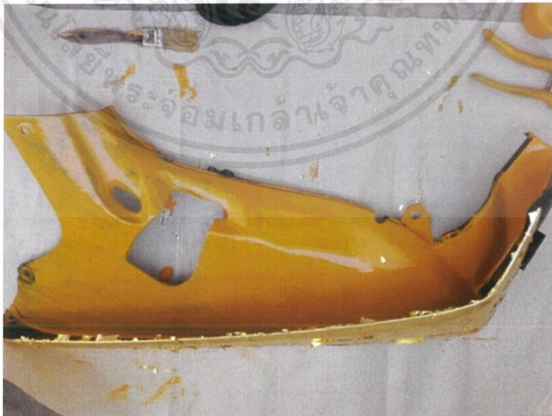
ภาพที่ 3.24 ทาสีเฟล็กซ์อีกด้าน
