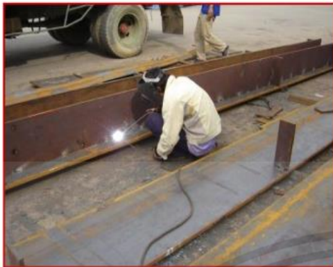
รูปที่ 2.5 แสดงการเชื่อมงานโครงสร้างขนาดใหญ่
