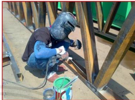
รูปที่ 2.5 แสดงการเชื่อมงานโครงสร้างขนาดใหญ่
