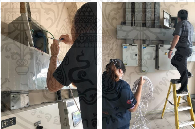
รูปที่ 3.5 (ก) ติดตั้งชุดมิเตอร์เข้ากับเกตเวย์ของทางท่าอากาศยาน ที่อาคาร AMF1 (ข) ติดตั้งชุดมิเตอร์เข้ากับเกตเวย์ของทางท่าอากาศยาน ที่อาคาร AMF1
