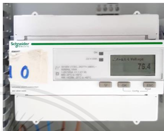
รูปที่ 3.13 (ก) ค่าแรงดันไฟฟ้า (L-L avg) ระหว่างค่าที่แสดงผ่านซอฟต์แวร์จากเครื่อง Server (ข) ค่าที่แสดงผ่านมิเตอร์ ยี่ห้อ Schneider รุ่น IEM3355 (Serial Number: 2519114056)
