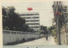
อาคาร ค. อาคารพาณิชย์
