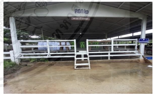
(ง) ไม่มีอ่างล้างมือ
