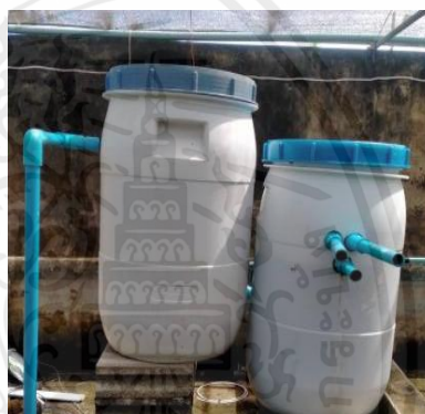
ภาพที่ 5 การประกอบระบบกรอง
