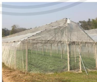
ภาพที่ 2.10 โรงเรือนหลังคาฟันเลื่อยหรือหลังคารูปกอกไก่
