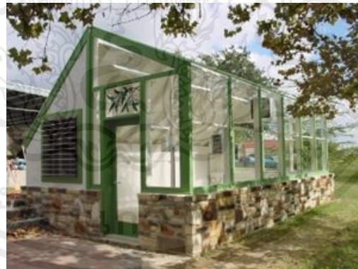
ภาพที่ 2.3 โรงเรือนหลังคาหน้าจั่วแบบไม่สมมาตร
