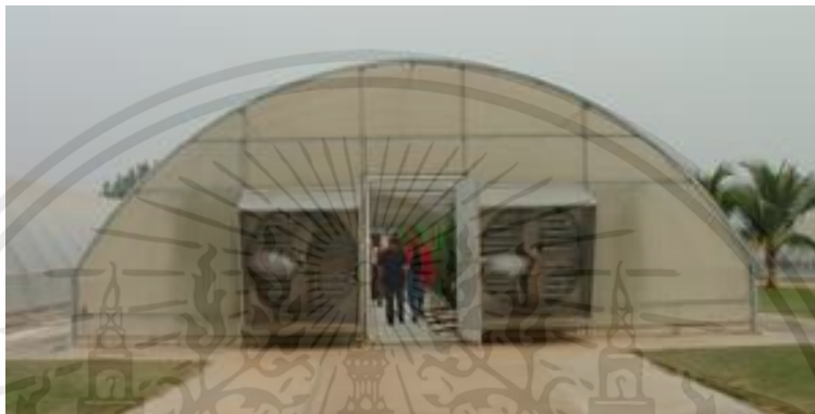
ภาพที่ 2.4 โรงเรือนหลังคาครึ่งวงกลม
