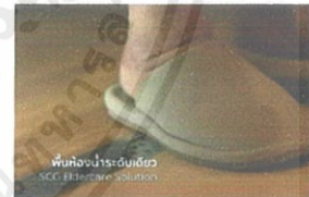
พื้นห้องนอนและห้องน้ำอยู่ในระดับเดียวกัน โดยใช้รางน้ำทิ้งสแตนเลสกันลื่นแบบแคบพิเศษ
