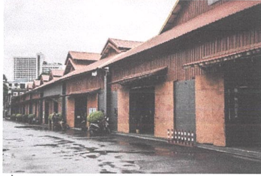
ภาพที่ 1. 28 แสดงด้านหน้าของอาคาร Warehouse 30
