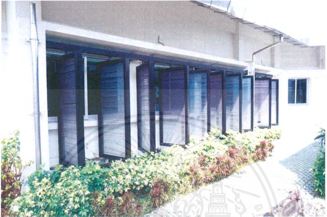
ภาพที่ 1.9.2.3 แสดงกระจกสองชั้นที่ใช้เพื่อลดความร้อน
