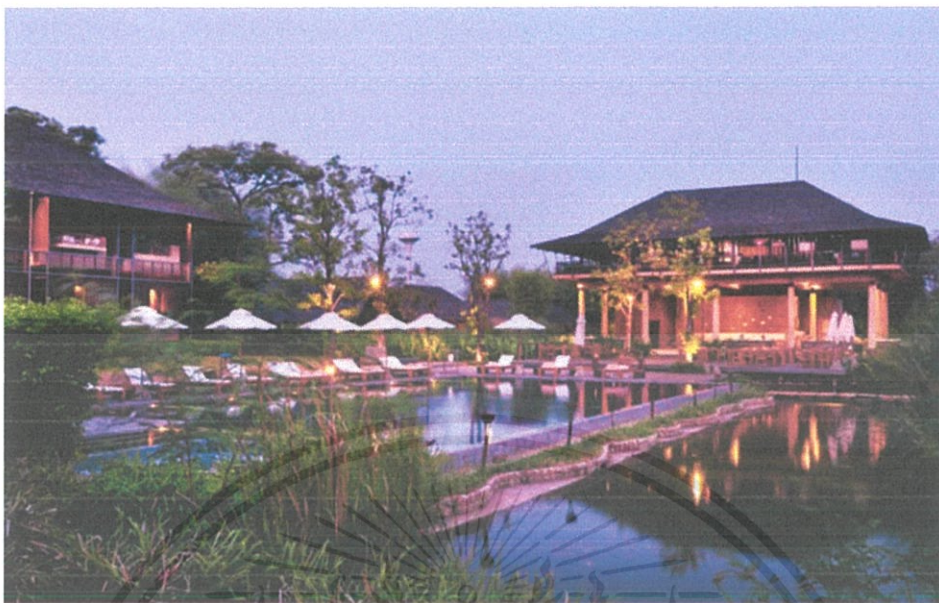
ภาพที่ 1.5 แสดงอาคารที่ 1
