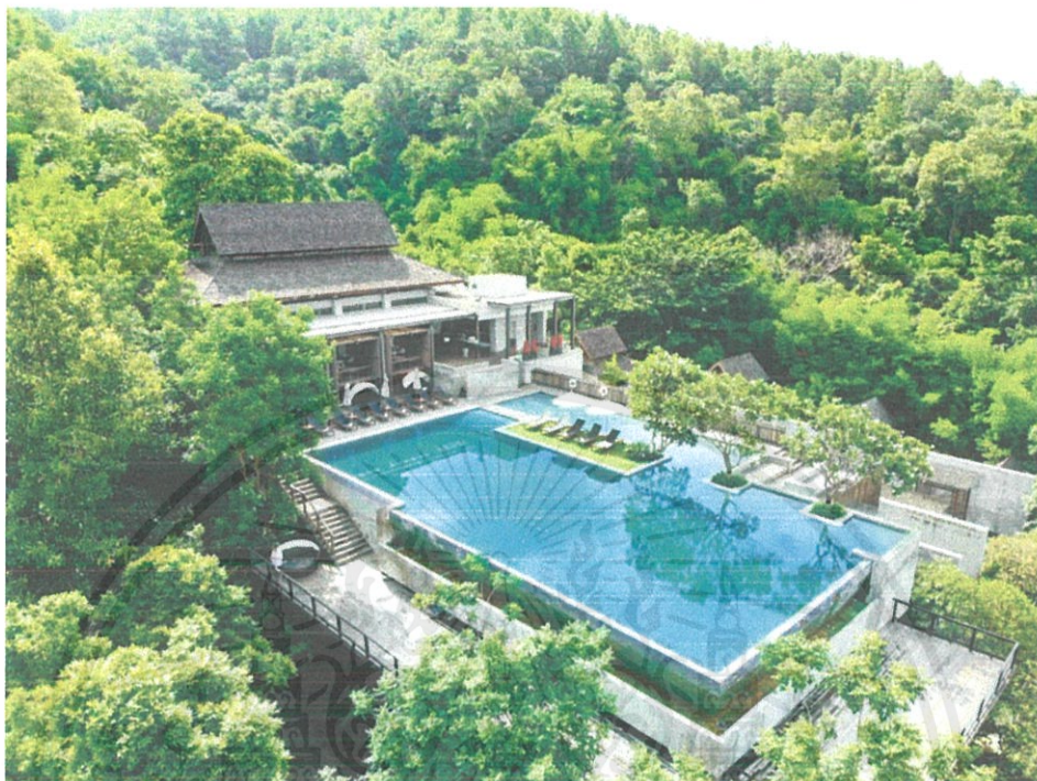
ภาพที่ 1.7 แสดงอาคารที่ 3
