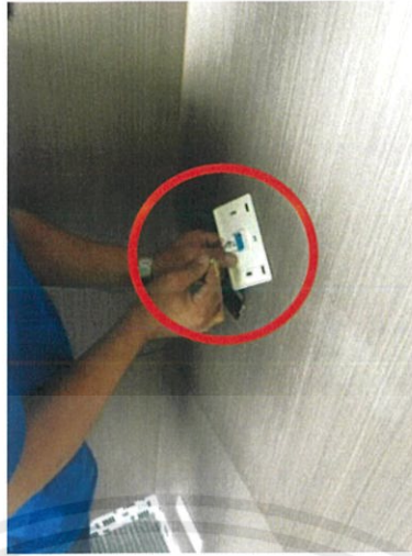
รูปที่ 3.13 เช็คความถึงกันของสายและเข้าอุปกรณ์
