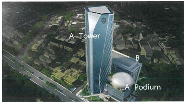
รูปที่ 3.1 โครงการก่อสร้างอาคารและตกแต่งภายในสำนักงานใหม่ การไฟฟ้านครหลวงคลองเตย
