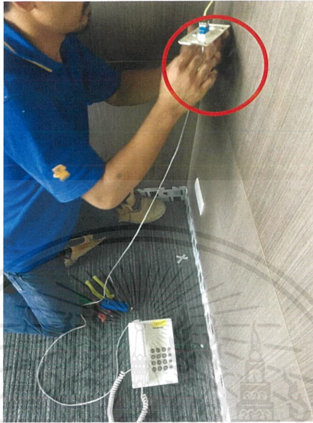
รูปที่ 3.21 การดูการเข้าหัว RJ-45 ไปพร้อมกับการทดสอบ
