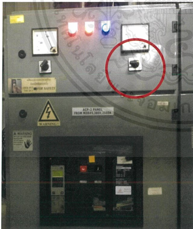
รูปที่ 3.6-4 ตำแหน่งในการติดตั้งพาวเวอร์มิเตอร์ที่ ACP#2
