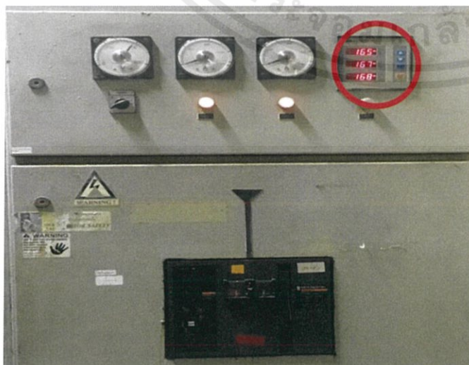
รูปที่ 3.6-12 ตำแหน่งในการติดตั้งพาวเวอร์มิเตอร์ที่ ZR400#1 ไม่อนุญาติให้นำไปใช้ประโยชน์ด้านการค้า ไม่ว่ากรณีใดๆทั้งสิ้น อีกทั้งห้ามมิให้ดัดแปลงเนื้อหา 25 ต้องอ้างอิงถึงเจ้าของเอกสารทุกครั้งที่มีการนำไปใช้
