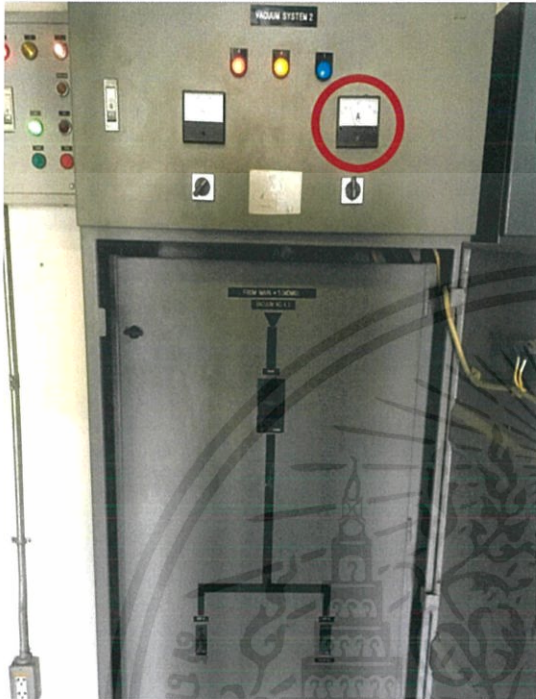
รูปที่ 3.6-8 ตำแหน่งในการติดตั้งพาวเวอร์มิเตอร์ที่ Vacuum 45
