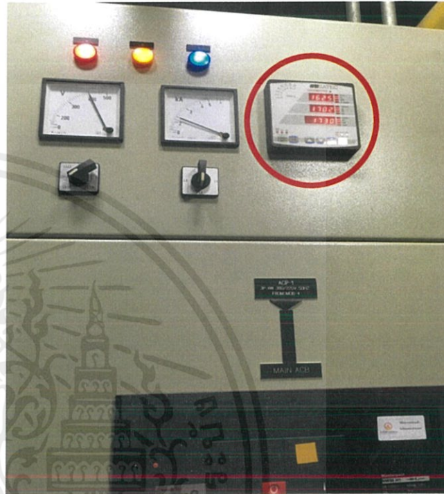
รูปที่ 3.6-2 ตำแหน่งในการติดตั้งฟาวเวอร์มิเตอร์ที่ ACP#
