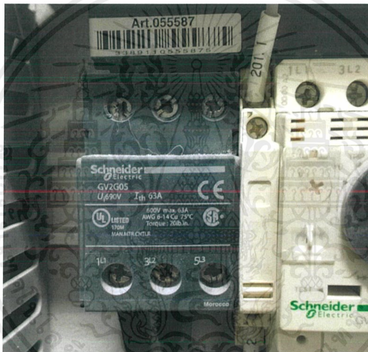
รูปที่ 3.37 เทอร์มินอลบล็อก (TERMINAL BLOCK)
