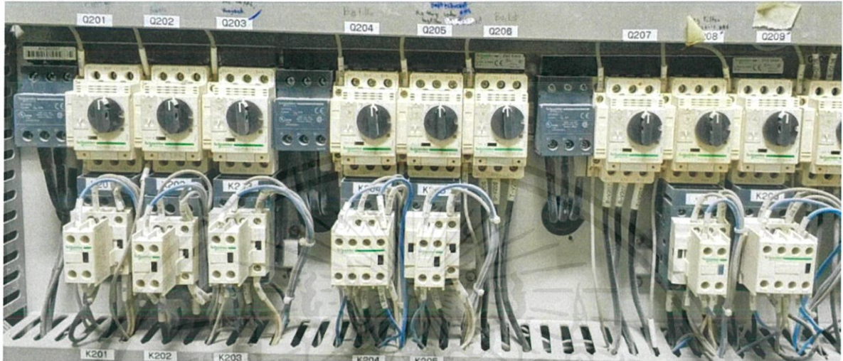
รูปที่ 3.18 เซอร์กิตเบรกเกอร์วงจรกำลังของเครื่องจักรในระบบลำเลียงปูน
