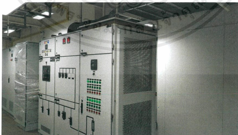
รูปที่ 3.39 ตู้ MDB ของห้องไฟ CG2
