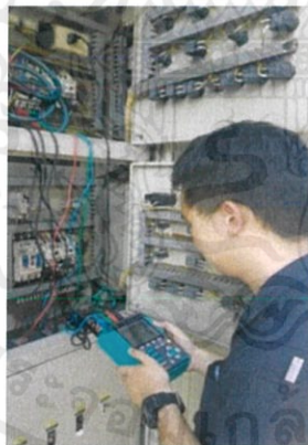
รูปที่ 3.11 การตรวจวัดกำลังไฟฟ้า บริเวณโกดังเก็บของเอ
