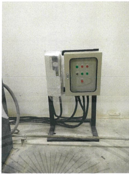
รูปที่ 3.12 ประกอบตู้ควบคุม VSD และ Support เข้าด้วยกัน
