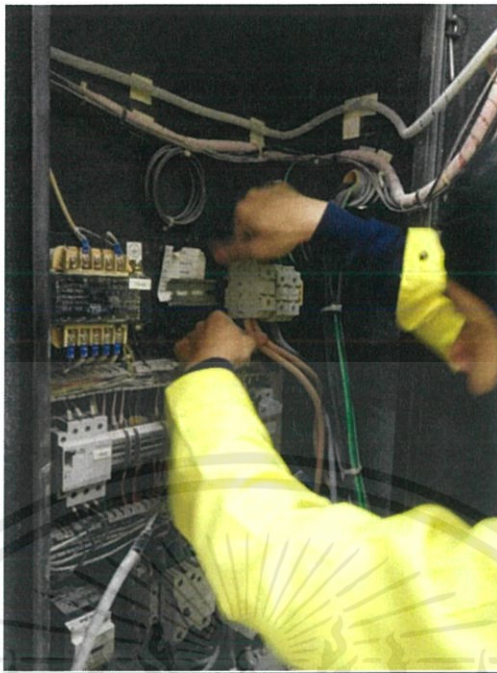
รูปที่ 3.24 เช้าสายตู้ Air compressor ให้ทำงานตามวงจรที่ออกแบบไว้
