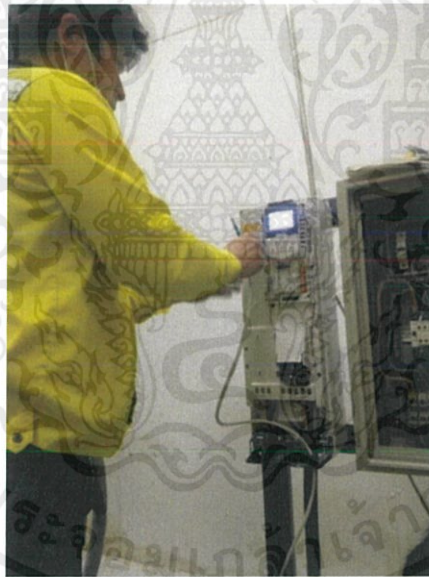
รูปที่ 3.25 ตั้งค่าการทำงานของ Inverter
