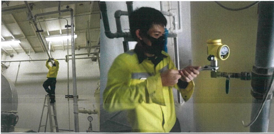
รูปที่ 3.21 ทำSupport ในการยึดท่อ และ Pressure transmitter
