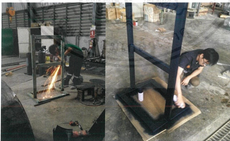
รูปที่ 3.11 ทำ Support ในการยึดตู้ควบคุมและ VSD ให้อยู่มั่นคง
