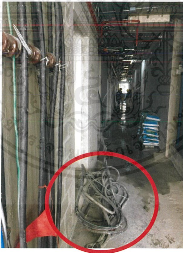
รูปที่ 3-22 แสดงการใช้งานสายผิดลักษณะการใช้งาน
