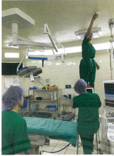
ภาพที่ 3.13 การทดสอบการทำงานของอุปกรณ์ตรวจจับควัน
