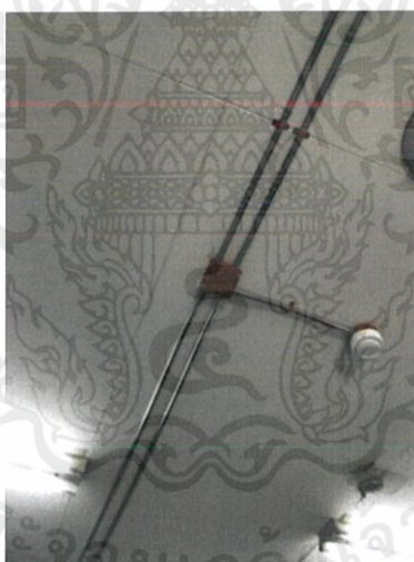
ภาพที่ 3.12 กล่องพักสายไฟที่ไม่ได้ทำการพันสี
