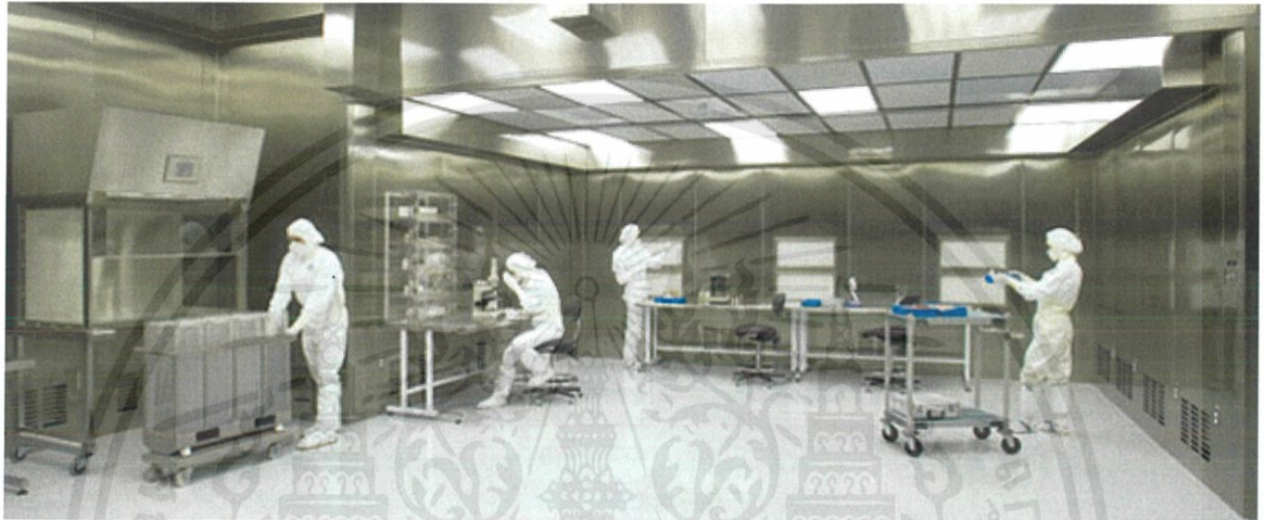
(รูปที่ 2.15 แสดงรูปห้องคลีนรูทในคลาส 10K)
