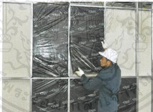
ภาพที่ 2.7 แสดงตัวอย่างการติดตั้งแผ่นกันเสียง
