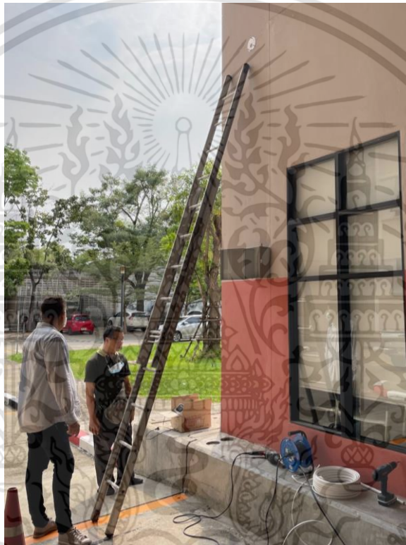
รูปที่ 4.85 การเจาะผนังเพื่อทำการติดตั้งกล่องและกล่องควบคุม
