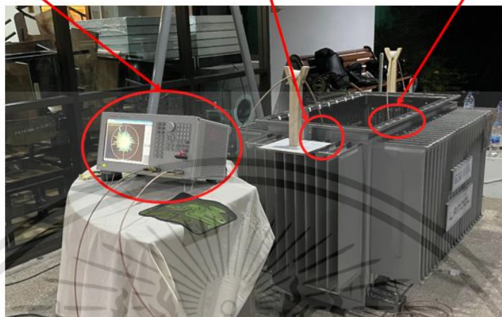
รูปที่ 3.26 การจัดเตรียมอุปกรณ์สำหรับการทดลองการวัดสัญญาณในหม้อแปลงไฟฟ้า กรณีไม่มีสิ่งกีดขวางและมีสิ่งกีดขวาง
